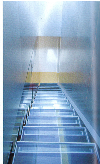
Hinterleuchtete Glasstufen führen in die Geschosse. Ein Oberlicht versorgt über Fensterbänder im Treppenschacht die Innenräume zusätzlich mit Licht.
